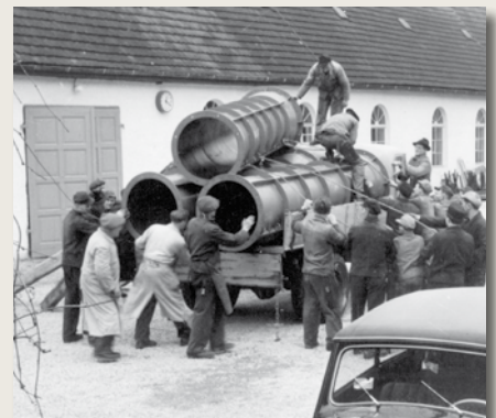
Cargar moldes de hormigón sobre un camión requería en 1940 aún de mucho esfuerzo manual
