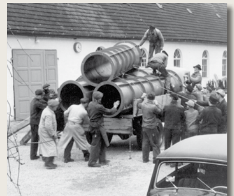
En 1940, le chargement sur un camion de moules pour tubes en béton demandait encore beaucoup d'efforts manuels
