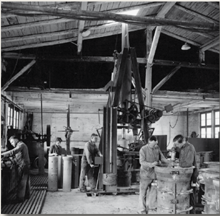
Hall de production Ettlingen env. 1938
