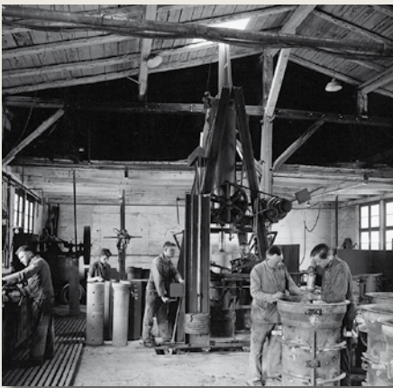
Hala produkcyjna w Ettlingen, ok. 1938 r.
