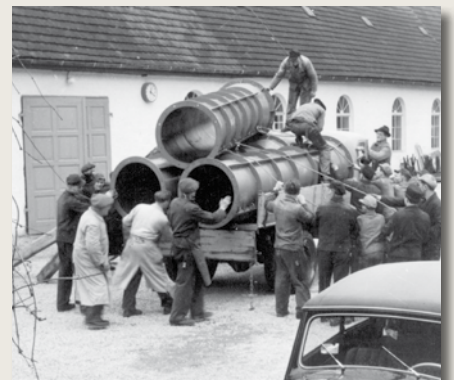
Przeładunek form dla rur betonowych na samochód ciężarowy wymagał w 1940 r. jeszcze wiele pracy ręcznej
