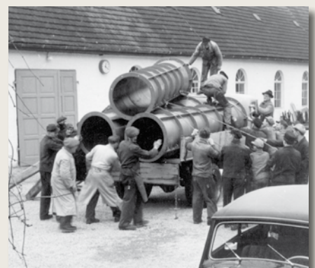
В 1940 г. погрузка на грузовой автомобиль форм для бетонных труб еще требовала много ручного труда.
