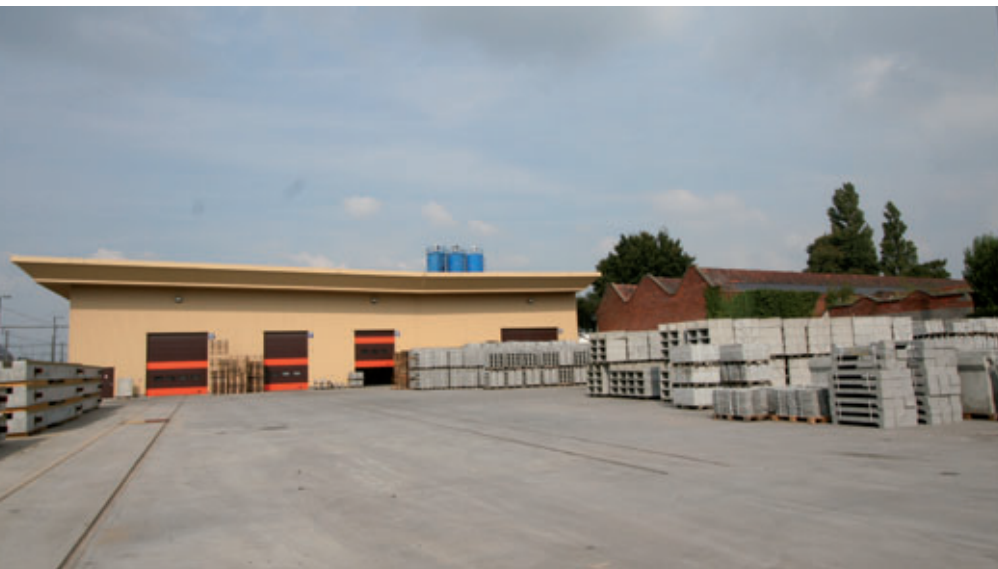
Das modern ausgerüstete Betonwerk von Infrabel in Roeselare
