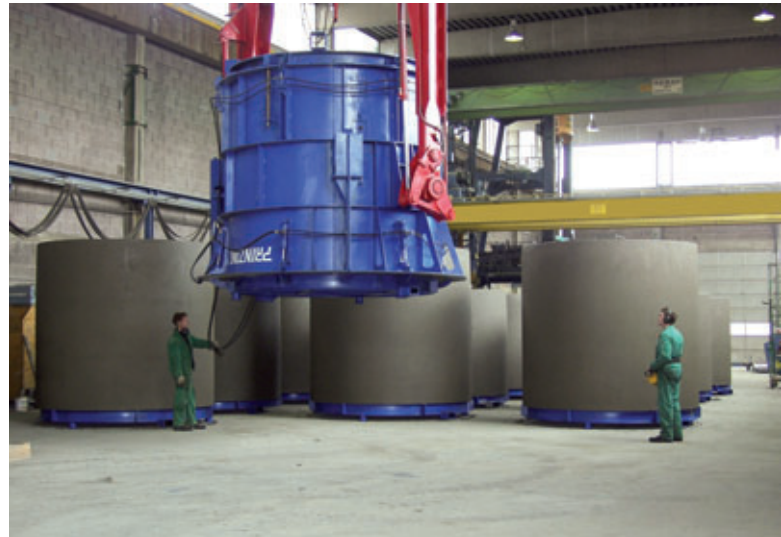
Behälterfertigung mit integrierter Abdeckplatte
