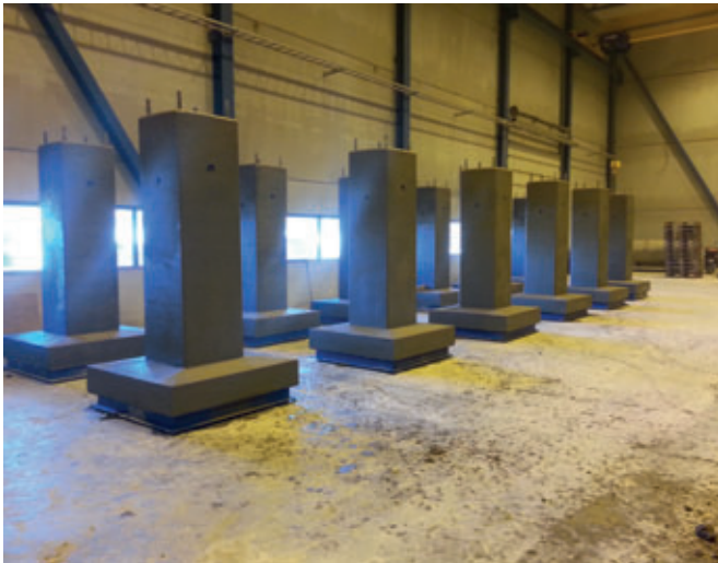
Fundamentblöcke mit Fuß
