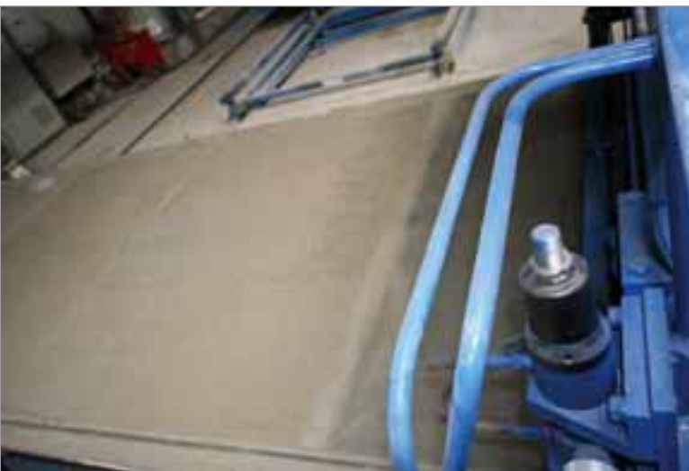
Beton ist hochverdichtet und planeben mit der Form
